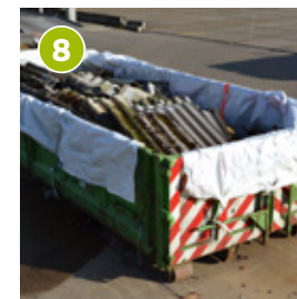
Deponeer het hechtgebonden asbest in de container met liner. Let op dat u het materiaal niet breekt of neergooit.
