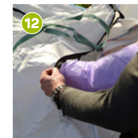
Deponeer ook de persoonlijke beschermingsmiddelen, gebruikte folie en poetsdoeken in de zak. Sluit de zak nu volledig.
